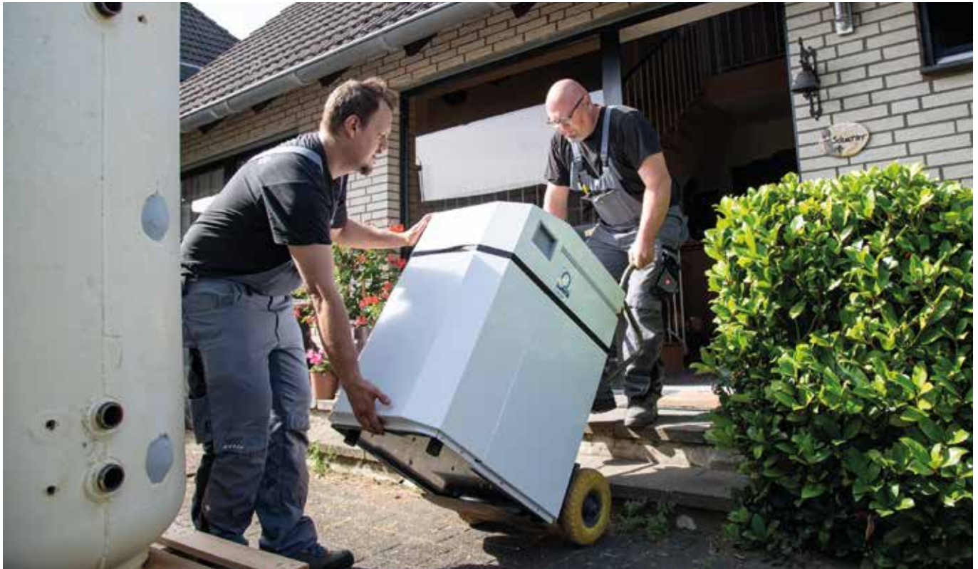
! Nach dem Abbau des alten Heizkessels zieht die neue Wärmepumpe ein.
