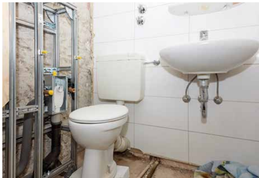
! Sanierung im bewohnten Zustand: Während auf der einen Wandseite das Geberit Installationssystem mit Anschlüssen für das neue WC installiert wird, können die Bewohner noch das alte WC und den Waschtisch nutzen.
