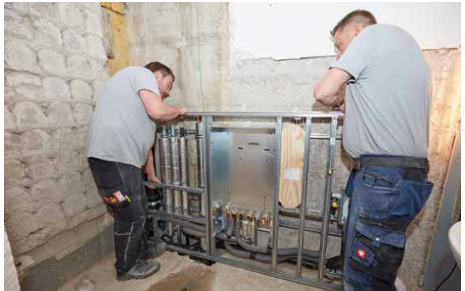
! An den vorgesehenen Stellen werden die GIS IV Installationswände angebracht und befestigt.
