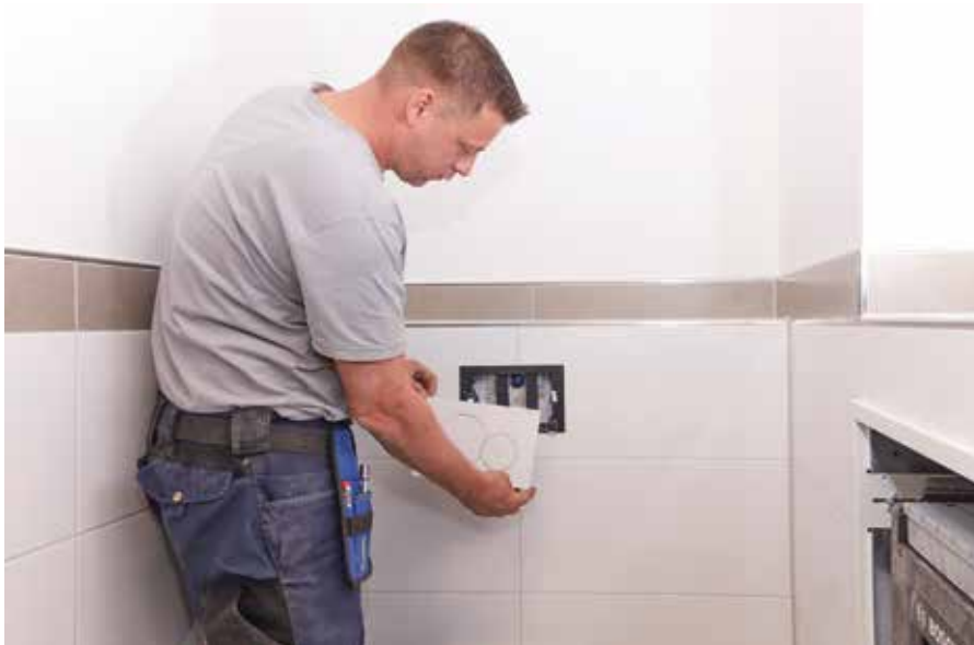
! Letzte Schritte: Die WC-Betätigungsplatte wird vom Installateur angebracht und die Bosch Wohnungsstation mit einer Abdeckplatte verschlossen.
