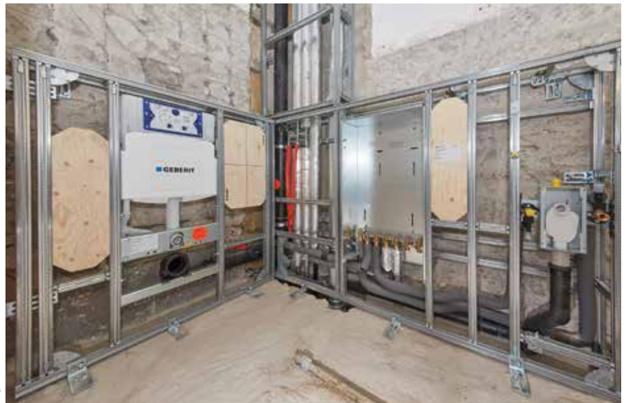
! Die einzelnen Teile der GIS IV-Wände werden L-förmig im Bad zusammengefügt. Sie enthalten neben den Trink- und Abwasserleitungen auch eine Aussparung für die Bosch Wohnungsstation, einen Geberit Unterputz-Spülkasten sowie ein Montageelement für den Waschtisch.
