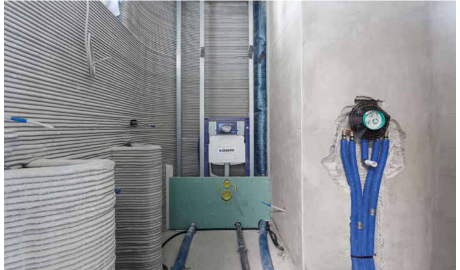
Das Entwässerungssystem Geberit Silent-PP zeichnet sich durch eine wirtschaftliche Installation und sehr gute Schalleigenschaften aus.
