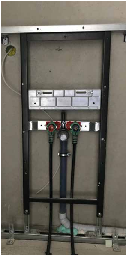
! „MEPA nextVIT“ Waschtischelement mit werkzeugloser Höhenanpassung der Traverse für den Wasser- und Abwasseranschluss.
