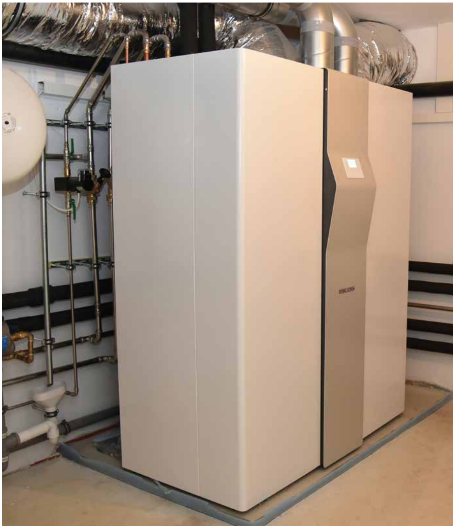
Ein Gerät für viele Funktionen: Das Allroundtalent LWZ 504 von Stiebel Eltron übernimmt in jedem Gebäude die Ent- und Belüftung, Beheizung, Warmwasserbereitung und auf Wunsch auch Kühlung.
