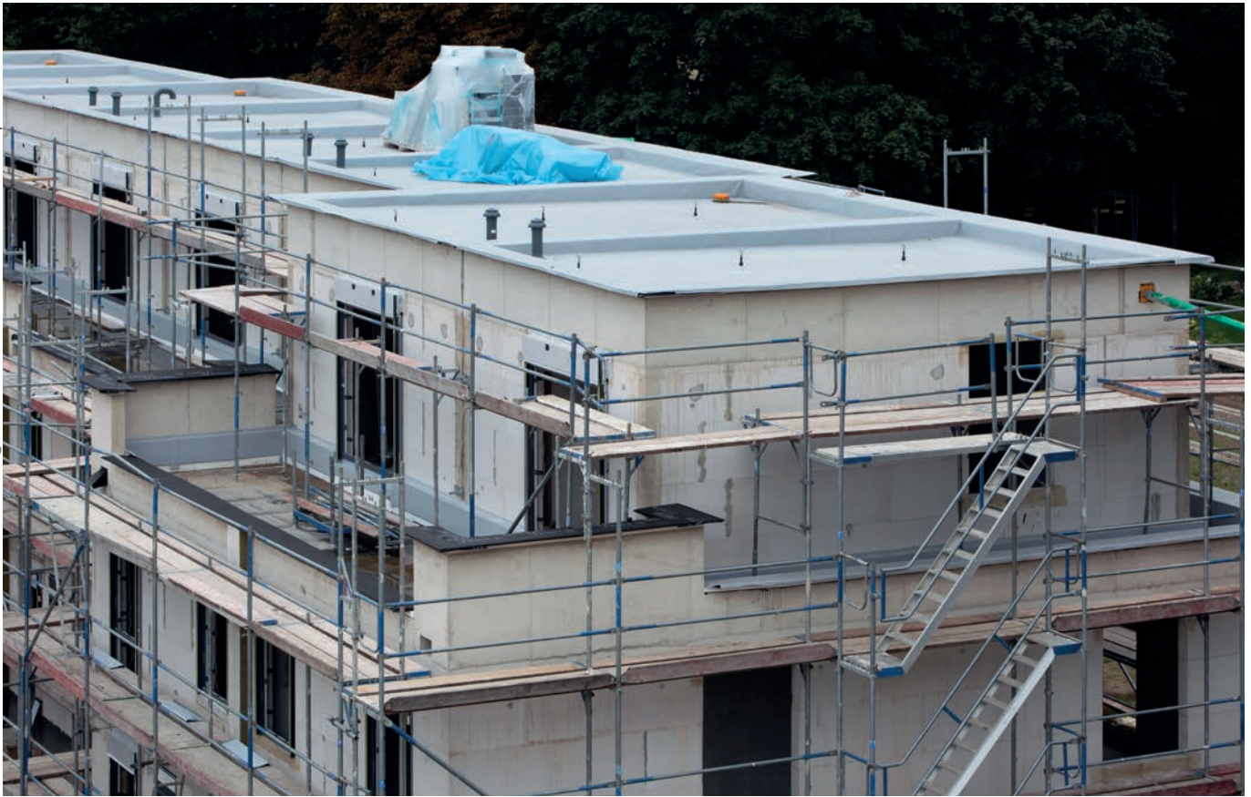
| Siedlungs-Neubau in Solingen. Das Gefälle des Flachdaches.
