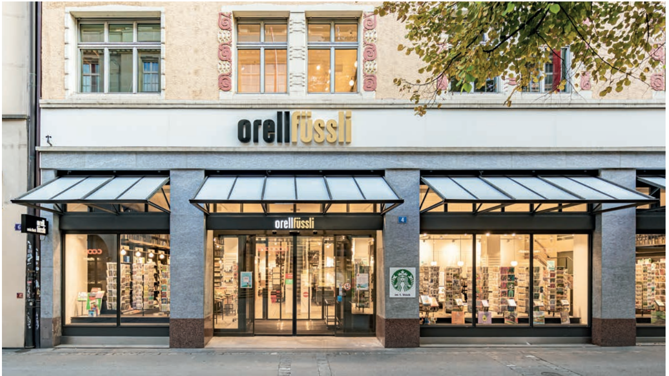
Der Eingangsbereich des Ladengeschäfts Orell Füssli Kramhof & Bookshop in Zürich wurde bei Nässe zur gefährlichen Rutschbahn.
