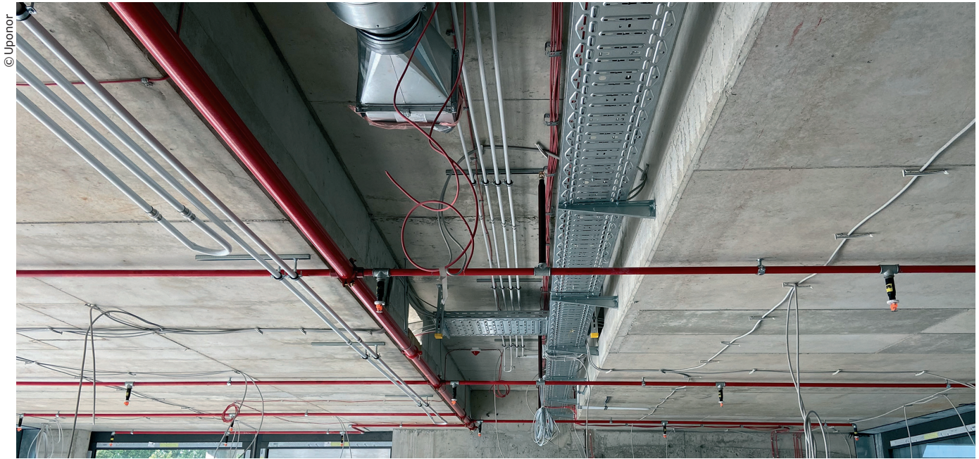
! So sehen die Decken vor Einbau der Module aus.
