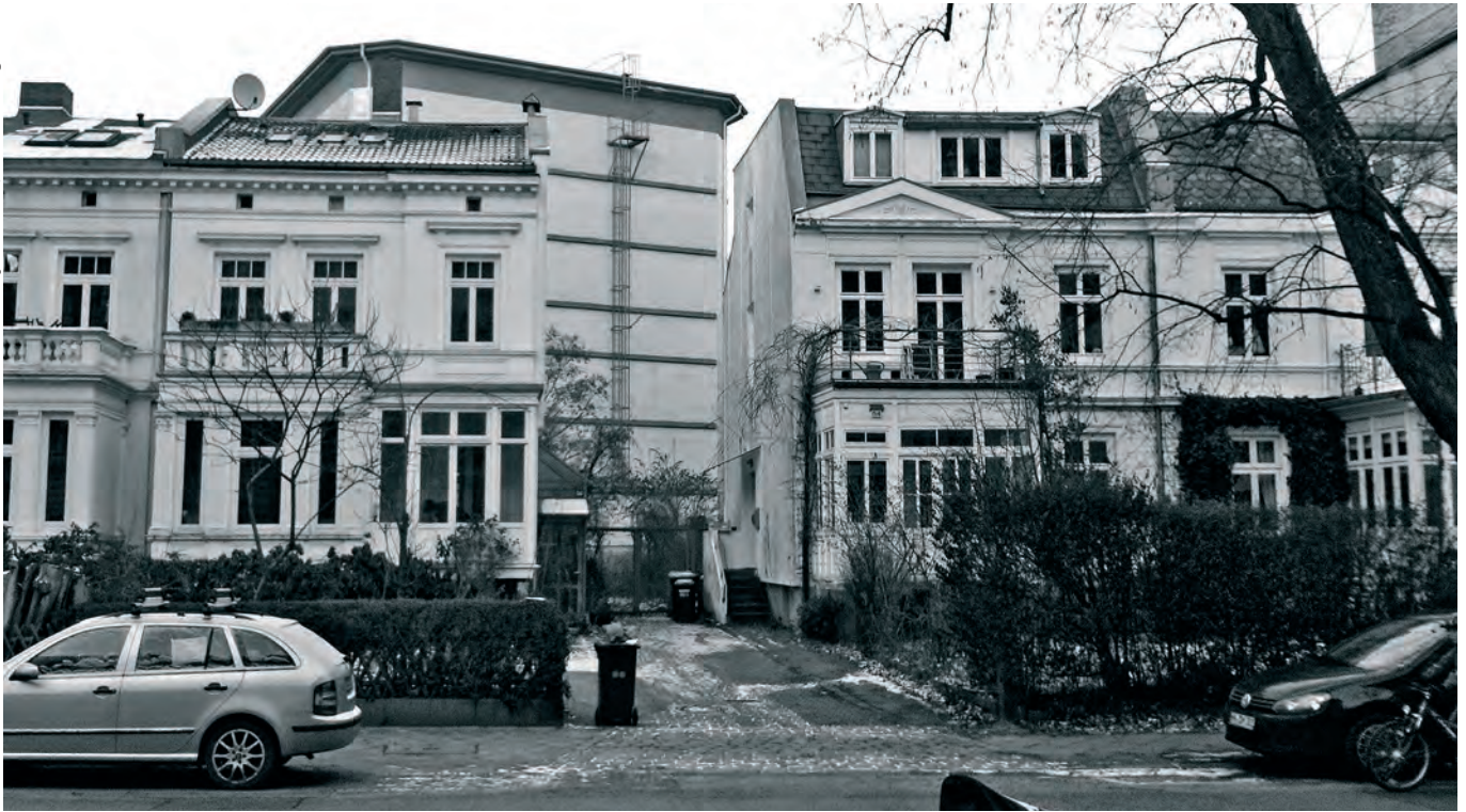
Der Hochbunker in Hamburg vor dem Umbau. Wo in Kriegszeiten 1.560 Personen Schutz finden konnten.
