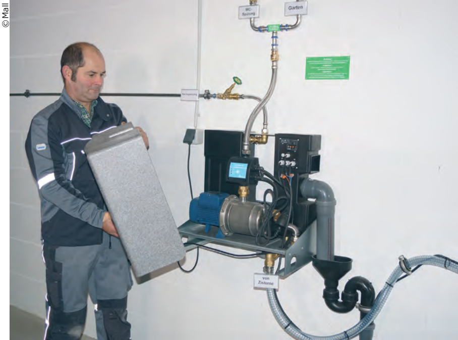
Regencenter Tano L vor dem Anbringen der Schallschutzhaube. Es ist ein komplett vormontiertes Hauswasserwerk mit Pumpen- und Steuerungstechnik sowie automatischer Nachspeisung gemäß DIN EN 1717.
