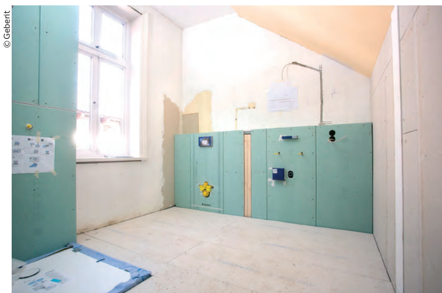
Nach der Montage des Installationssystems Geberit GIS wurde die Vorwand beplankt und anschließend gefliest.
