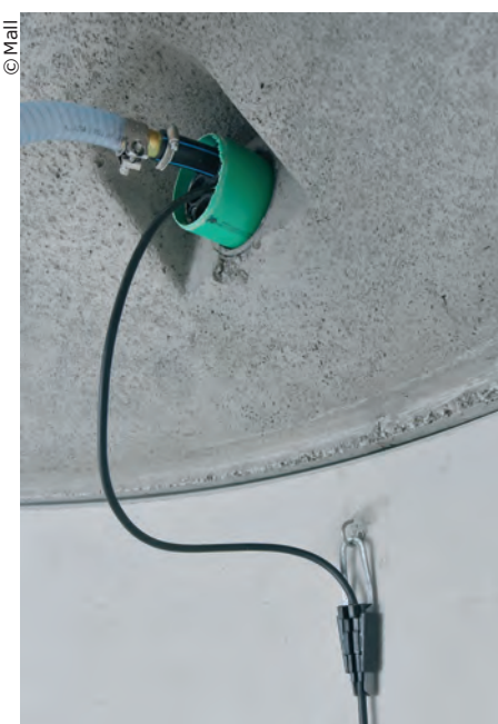
Für Rohrverbindungen sind Öffnungen mit Dichtungsmanschetten im Behälter vorhanden.
