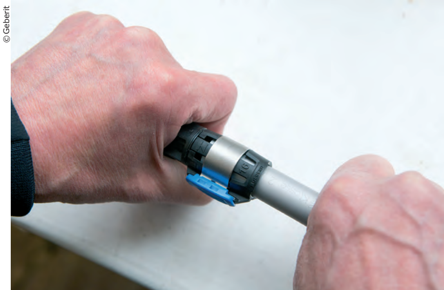
Über das Sichtfenster im Geberit FlowFit Fitting kann der Installateur die Einstecktiefe des Rohrs exakt kontrollieren.
