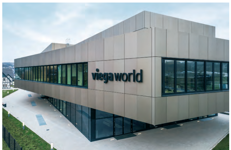
Das interaktive Weiterbildungszentrum „Viega World“ gilt als Leuchtturmprojekt für die Zukunft des Bauens, denn erstmals wurde ein Bildungsbau so konsequent integral mit der Arbeitsmethodik BIM realisiert. Viele der Erkenntnisse sind deshalb auch schon in die einschlägigen Normen und Regelwerke eingeflossen.
