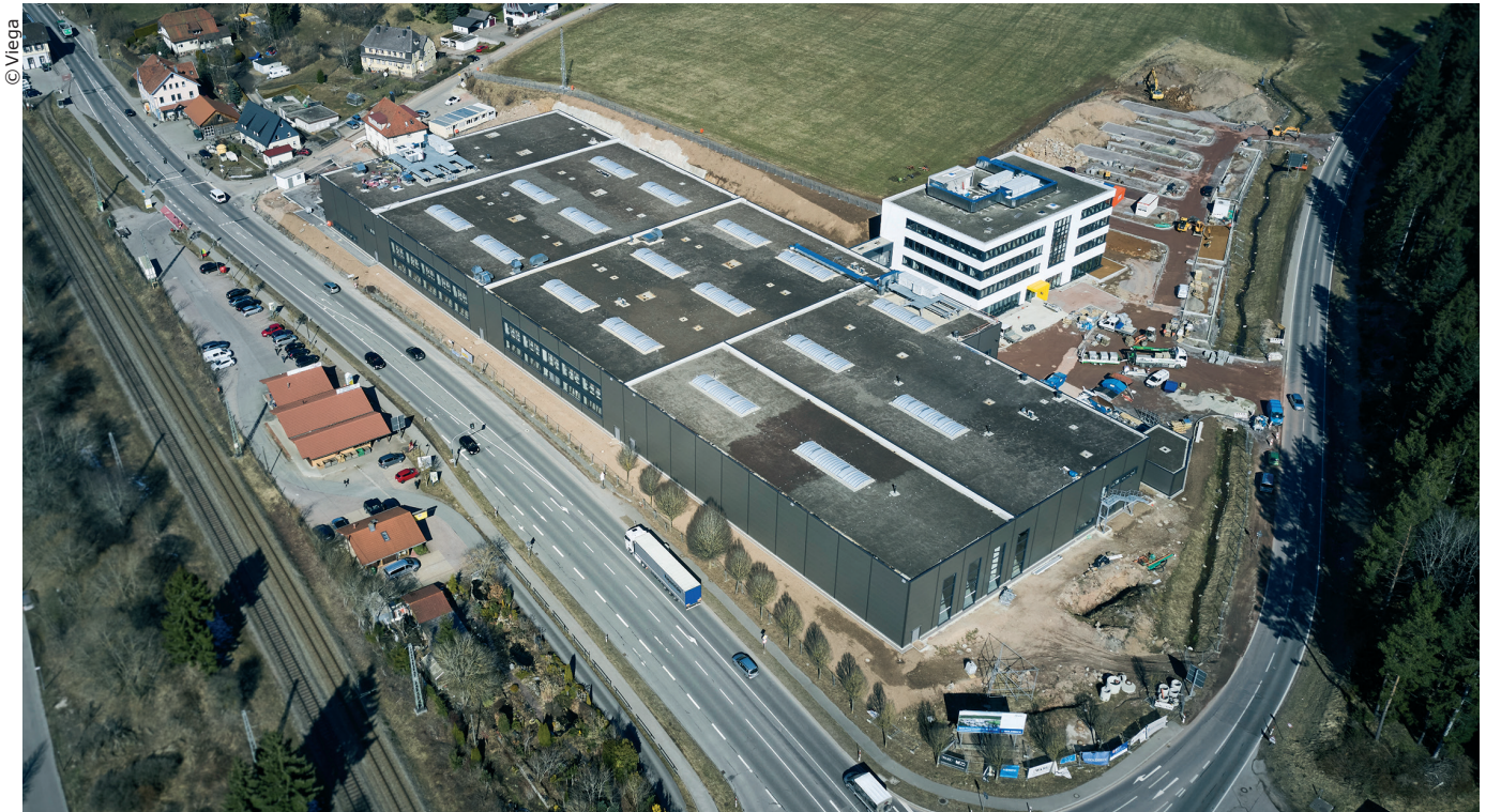
Die Wahl GmbH investiert in den neuen Standort in St. Georgen. Im Vordergrund, an der B 33, die weitläufigen Produktions- und Logistikhallen.
