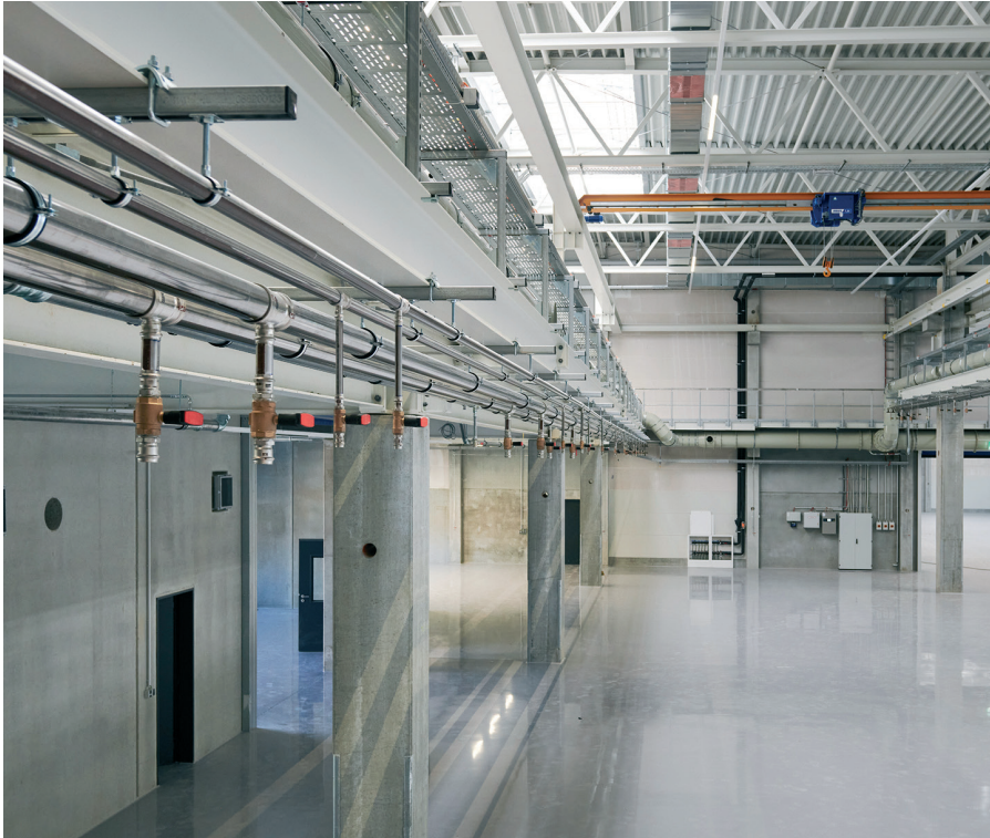
Die „Temponox“-Kühlleitungen (links unterhalb der Empore) an die jetzt im nächsten Schritt die metallverarbeitenden Produktionsmaschinen angebunden werden.
