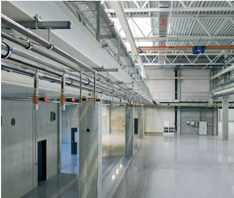
Die „Temponox“-Kühlleitungen (links unterhalb der Empore) an die jetzt im nächsten Schritt die metallverarbeitenden Produktionsmaschinen angehängt werden.
