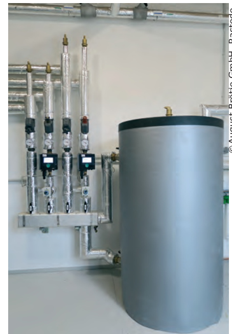
Der 825 Liter fassende Pufferspeicher überzeugt mit einem Zulaufanschluss in der Dimension DN 80; er versorgt zwei Heizkreise zuverlässig mit Wärme.
