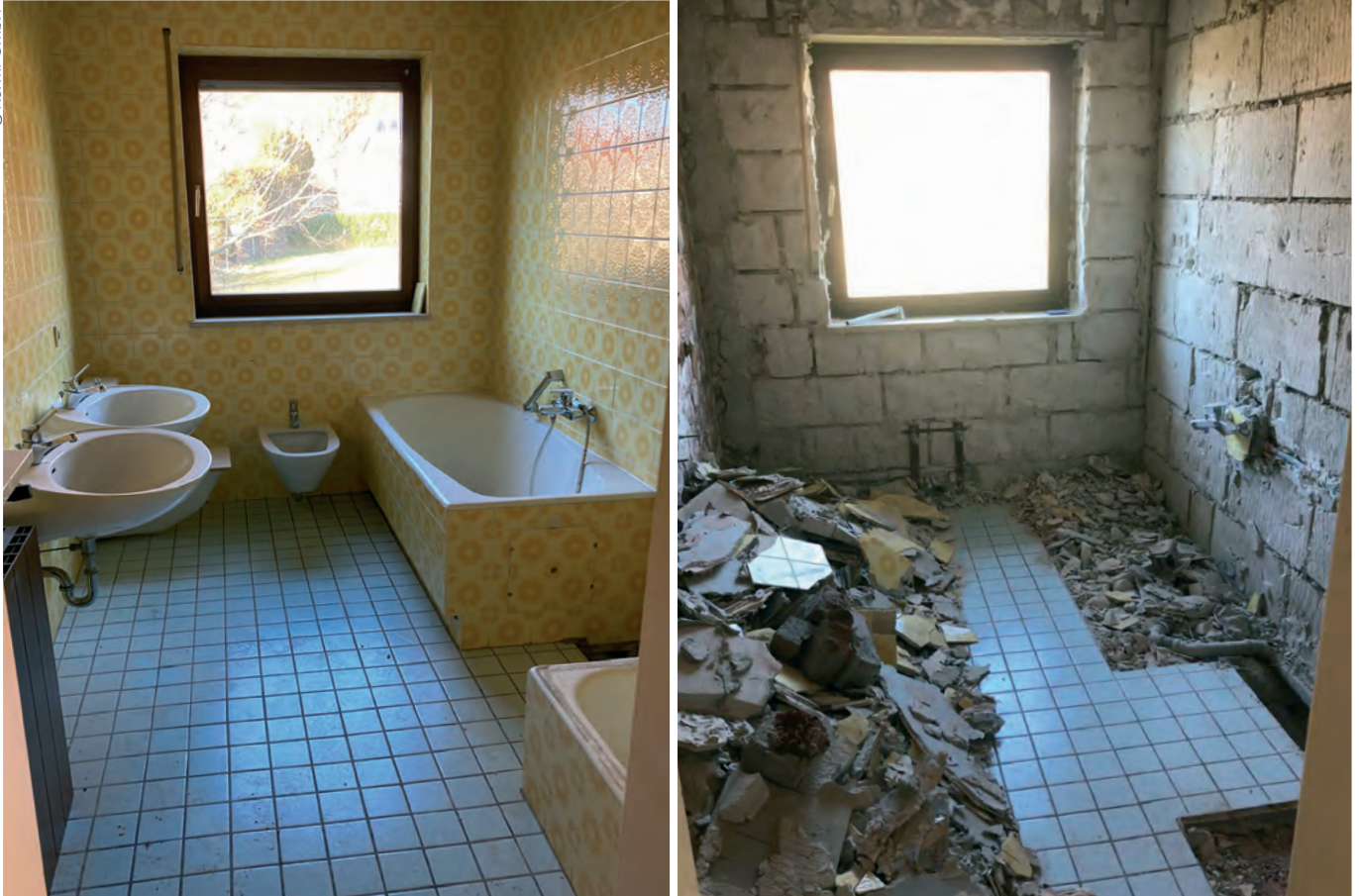
! Das Hauptbad des Hauses vor der Renovierung. Demontage aller Sanitäranlagen und Entfernung aller Fliesen an Wänden und Boden.
