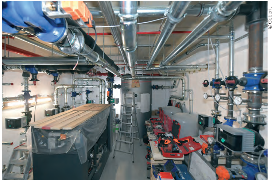
Hybride Anlage mit Wärmepumpe und Gasheizung für Büros und Fertigungshallen: In Kombination mit Photovoltaik wird ein Großteil an regenerativen Energien genutzt.
