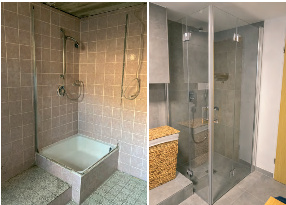
Der Duschbereich wird für das Kermi Duschboard vorbereitet. Die Duschkabine LIGA in Silber Hochglanz passt sehr gut zum Stil des Gästebades.
