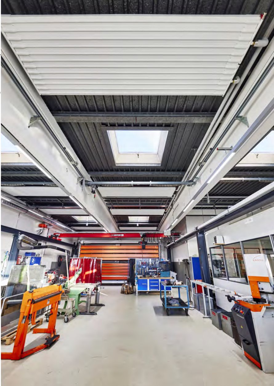
Die Wahl des Heizsystems fiel auf den Raumklimaspezialisten Zehnder aus dem benachbarten Lahr, dessen Deckenstrahlplatten Zehnder ZFP besonders leicht sind und über eine sehr hohe Strahlungseffizienz von bis zu 89 % verfügen.
