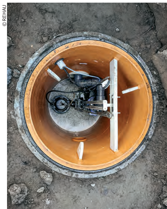
rechts: Der selbsttragende, korrosionsfreie und dauerhaft dichte Schacht wird auf die Baustelle geliefert und kann sofort eingesetzt werden.
