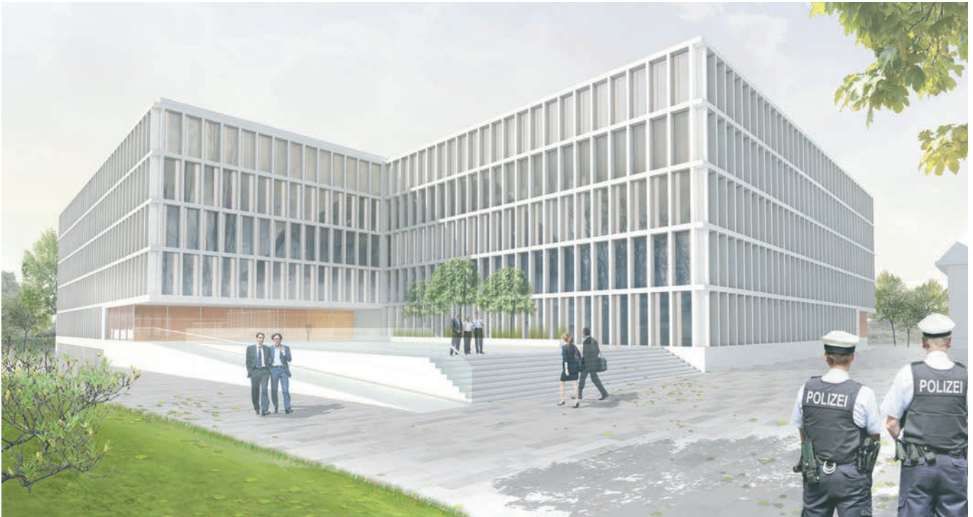
Ein Ensemble aus drei versetzten Baukörpern beherbergt das neue Bundespolizeipräsidium in Potsdam.
