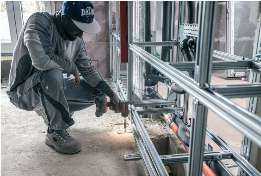
Die Geberit GIS IV Wände wurden in den Bädern vermessen und verschraubt.
