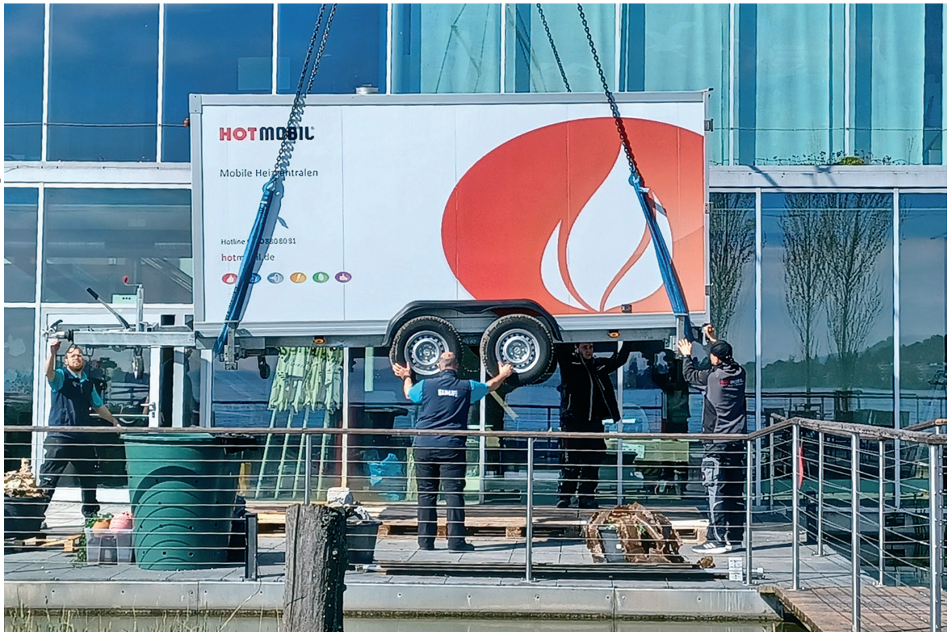
Mobile Heizzentrale wird mittels Krans auf der Terrasse platziert.
