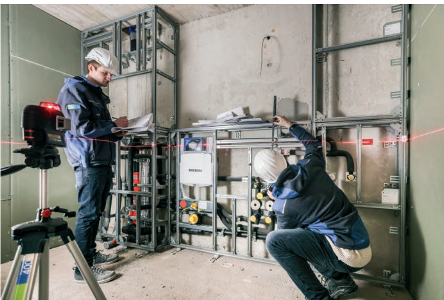
Das Register wird vom Ingenieurbüro mithilfe eines Lasers geprüft und abgenommen.
