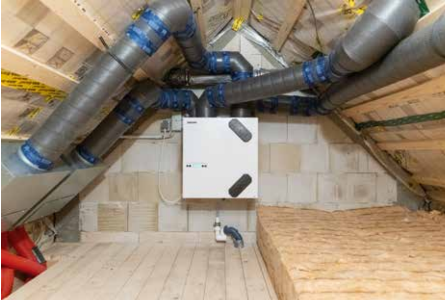
Die Realisierung der Zu- und Abluftleitungen erfolgte zum Teil über das Gebäudedach.
