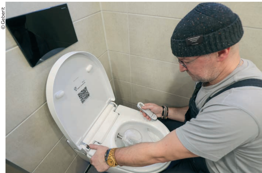
Nach erfolgter Installation testet der Monteur die Funktionen des Dusch-WCs, wie zum Beispiel den körperwarmen Wasserstrahl.
