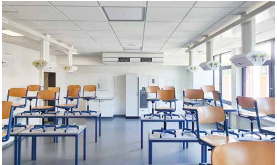
Die dezentralen Lüftungsgeräte aus der DUPLEX Vent Serie lassen sich raumweise, individuell und zielgerichtet steuern.
