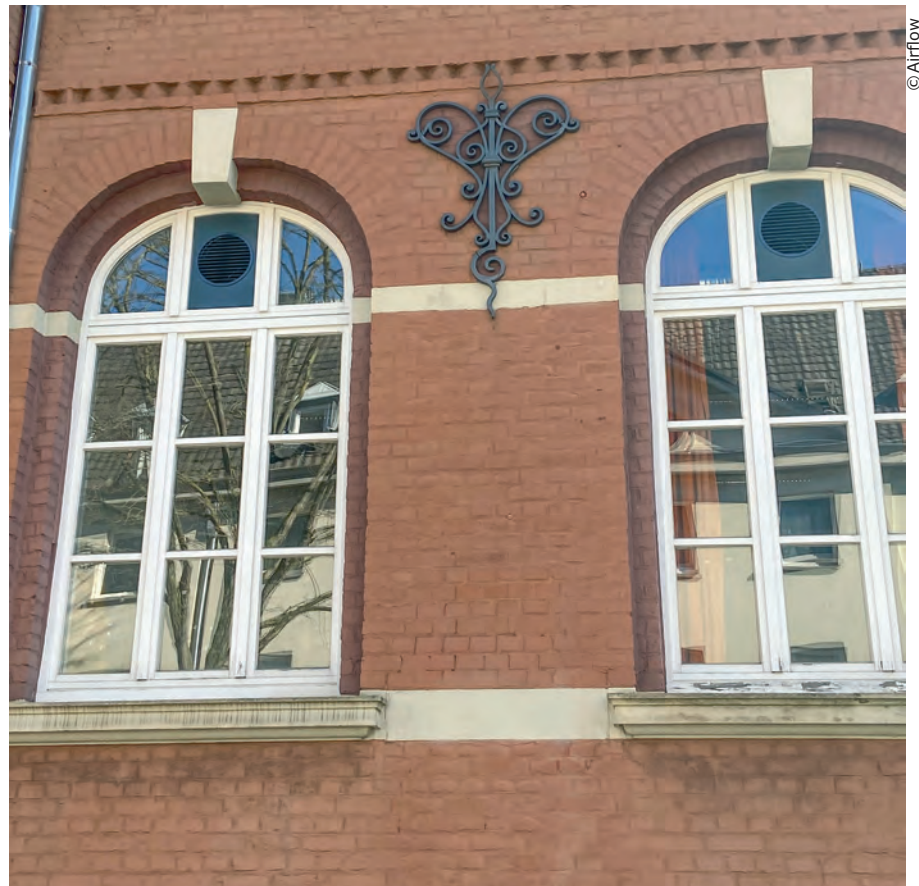
! Von außen quasi unsichtbar: Die Zugänge für Außen- und Fortluft integrieren sich perfekt in die Fassade.
