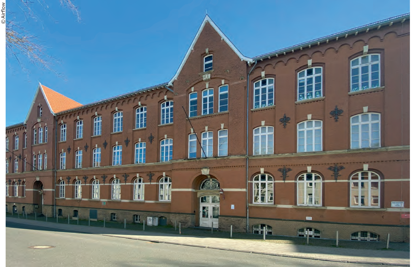
I Denkmalgeschützte Aachener Grundschule.
