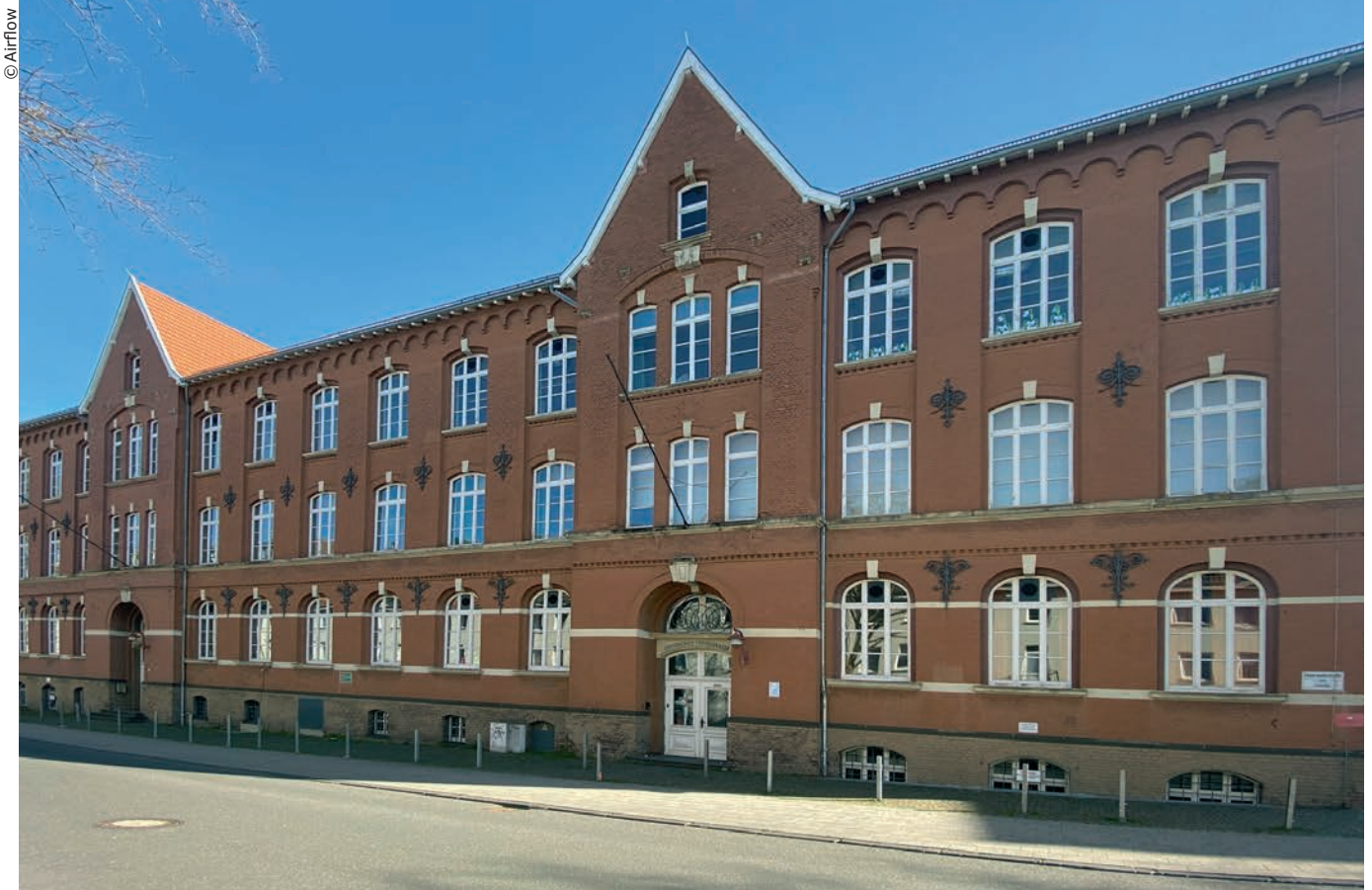
| Denkmalgeschützte Aachener Grundschule.
