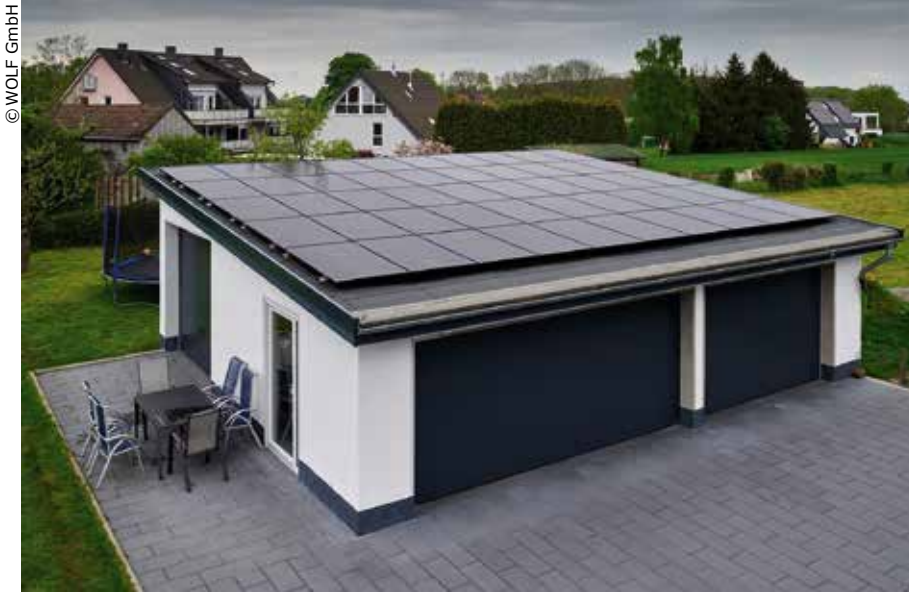
Die aus 50 Modulen rund 100 m 2 große PV-Anlage auf einem Nebengebäude hat eine Leistung von 21 kWp.
