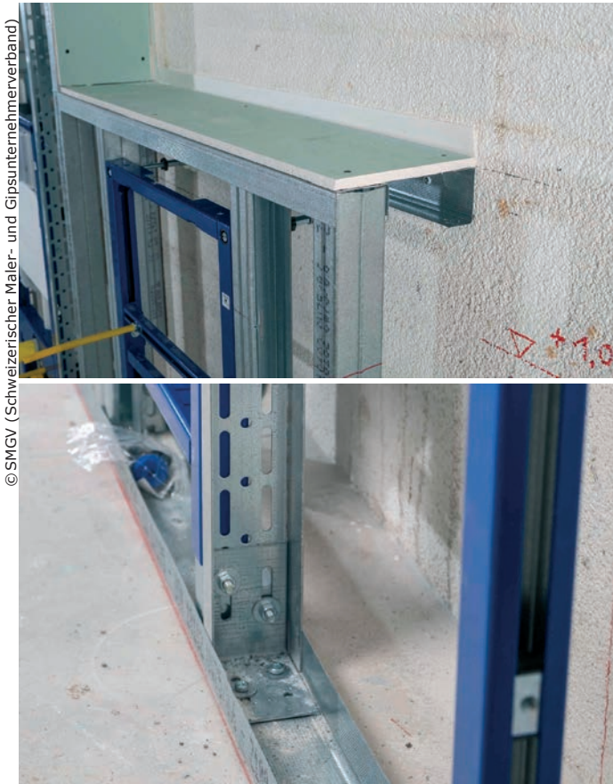
I oben: Beispielhafte Ausbildung der oberen Abdeckung einer teilhohen Vorwandinstallation. unten: Beispiel einer kraftschlüssigen Befestigung von UA-Profilen mit Anschlusswinkel am Rohfußboden.
