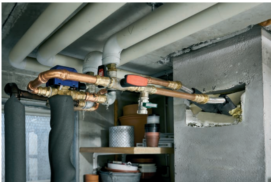
! Der nach dem Heizungstausch nicht mehr benötigte Kamin der alten Ölheizung wurde für die Rohrleitungsführung zu den Klimageräten im Obergeschoss genutzt.
