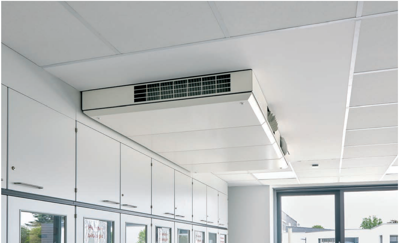
■ Dezent: Die dezentralen DUPLEX Vent Geräte lassen sich flexibel komplett oder teilweise in die Decke integrieren.
