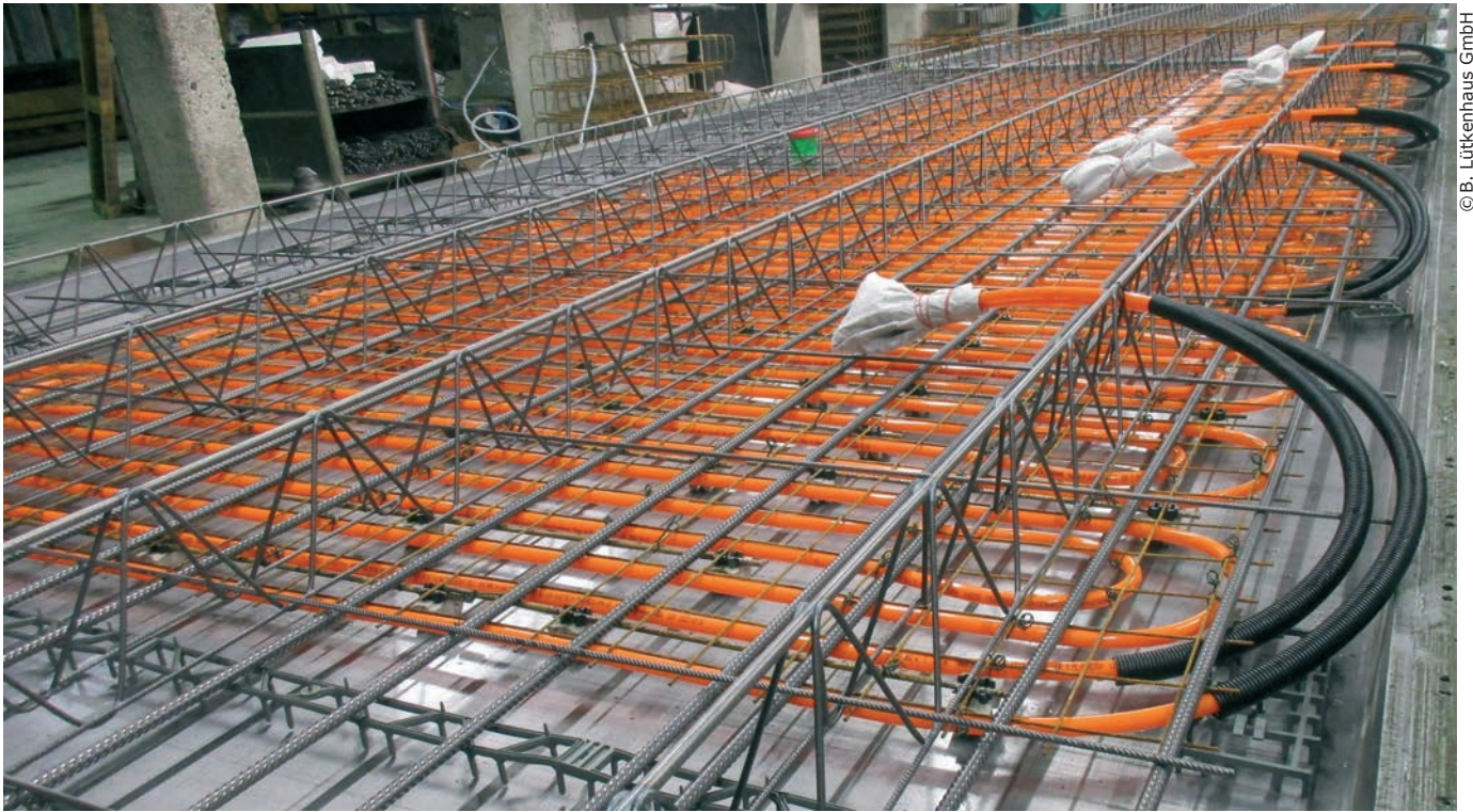
Die Lütkenhaus Klimadecke mit oberflächennaher Betonkerntemperierung mit Rohrmodulen von REHAU.
