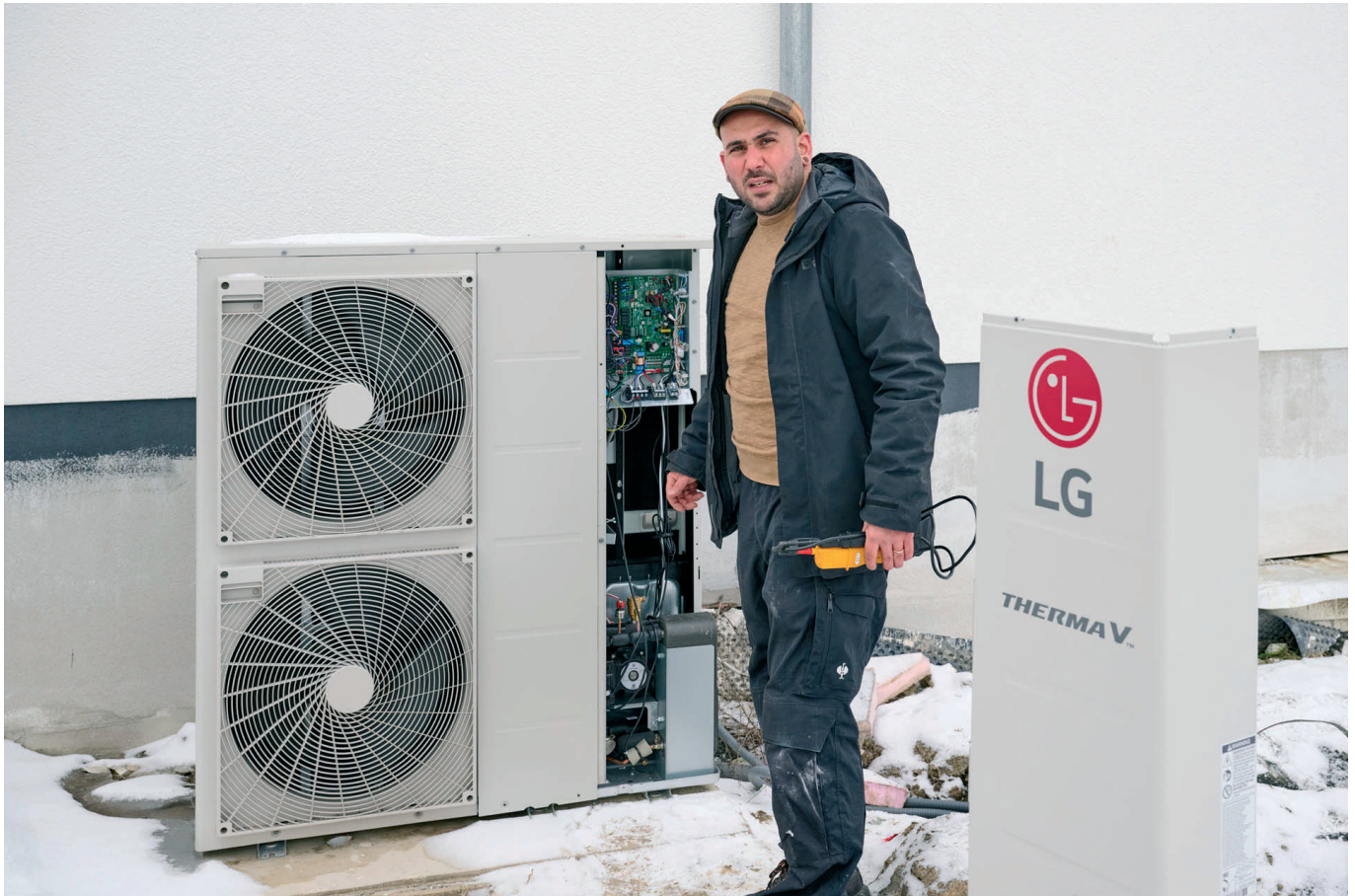
! Installations- und Heizungsbaumeister Umut Özdemir.
