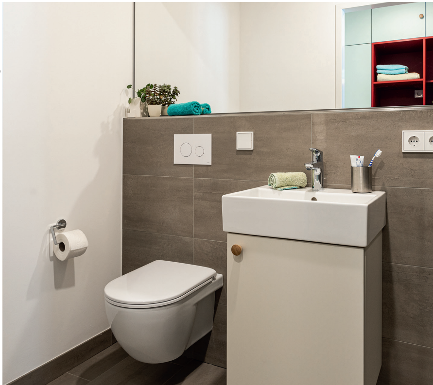
Die Betätigungsplatte TECEloop in weiß sowie eine helle, hochwertige Ausstattung charakterisiert das Innere der Badezimmer.
