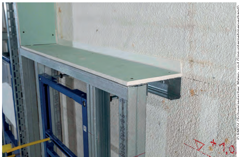
Beispielhafte Ausbildung der oberen Abdeckung einer teilhohen Vorwandinstallation.
