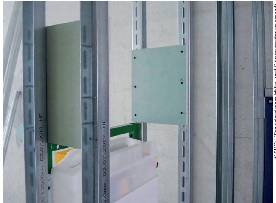
Verlaschung einer Doppelständerwand mit einem Plattenstreifen aus Gipskarton.
