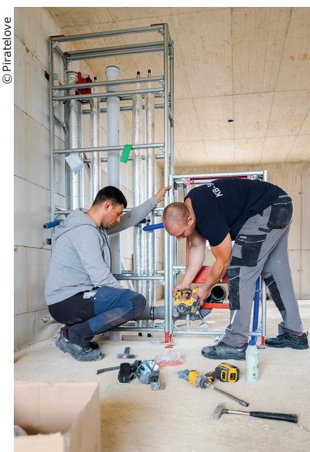
Zwei Handwerker bei der Montage des Trennwand-Moduls.
