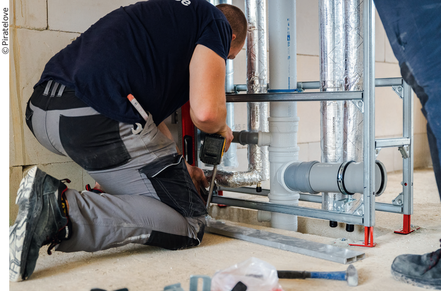
Ein Handwerker richtet die Installationswand am Boden aus.
